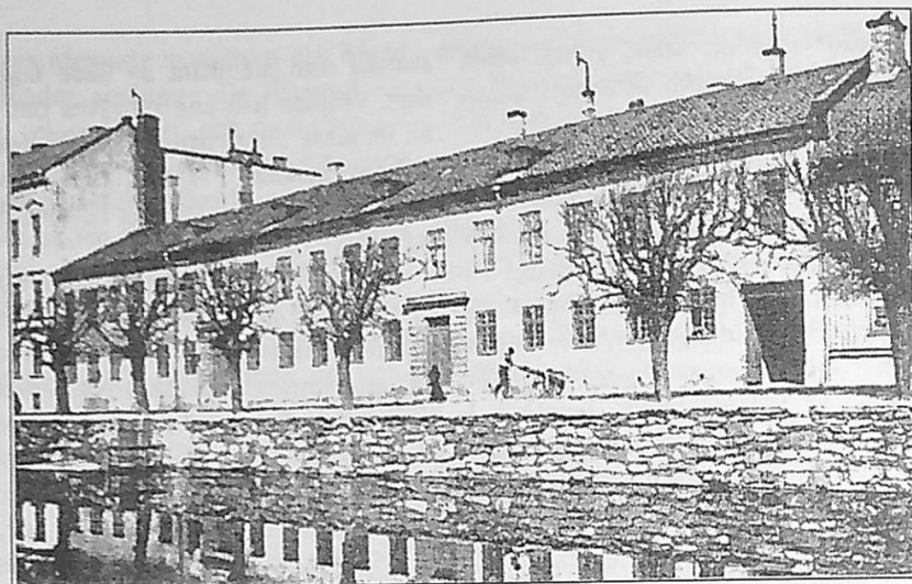
Willinska skolan vid Stampgatan, uppförd 1835
