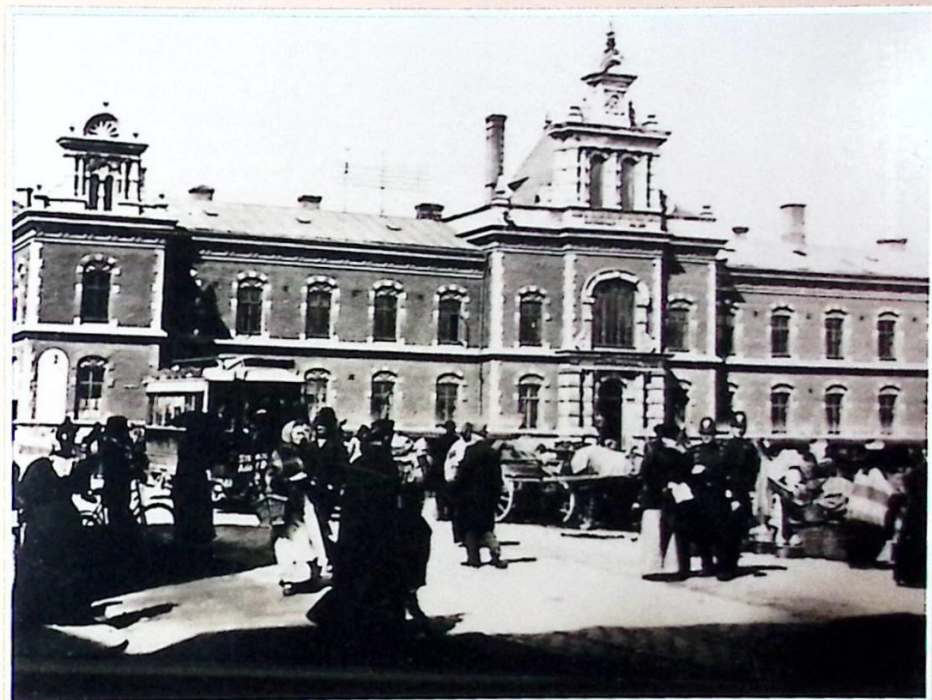
Det gamla sjömanshuset vid Masthuggstorget
